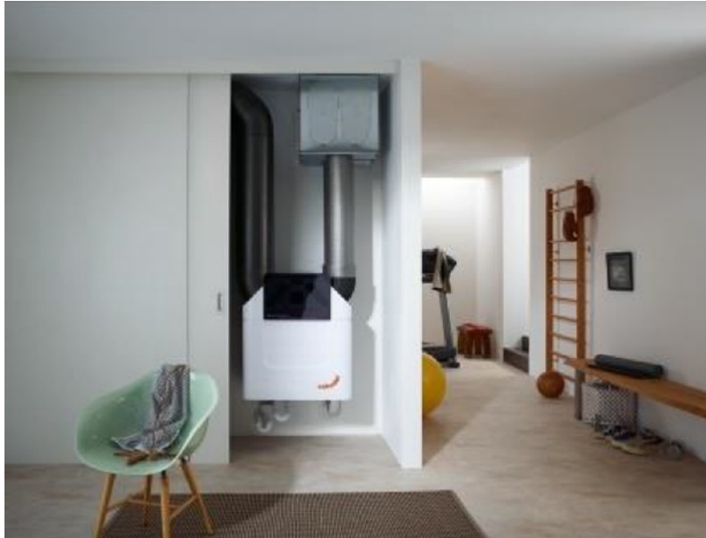
Abbildung 4: Lüftungsgerät in einer Wohnung (Quelle: Zehnder Group)
