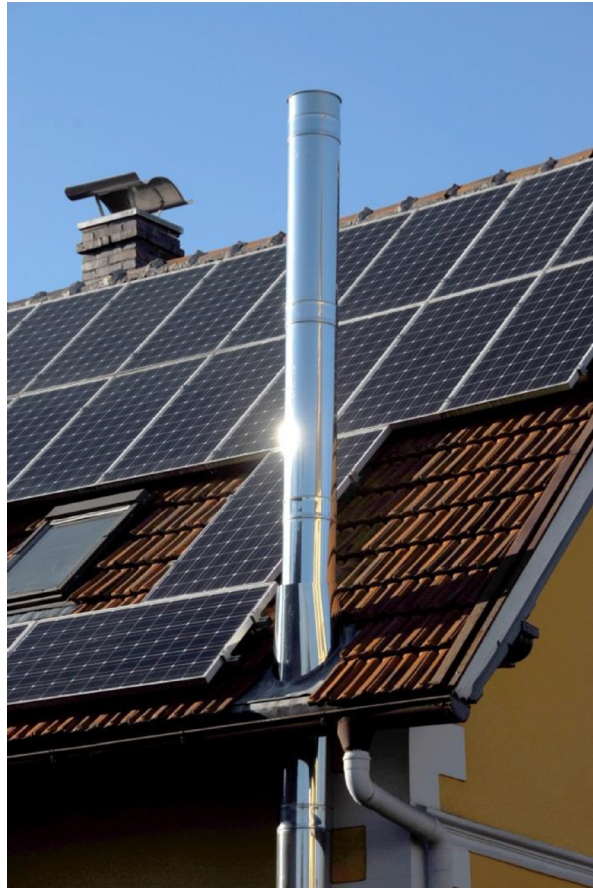
Abbildung 2: Abgasleitung (Quelle: H. D. Volz / pixelio.de)
